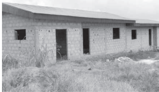
travaux de construction
